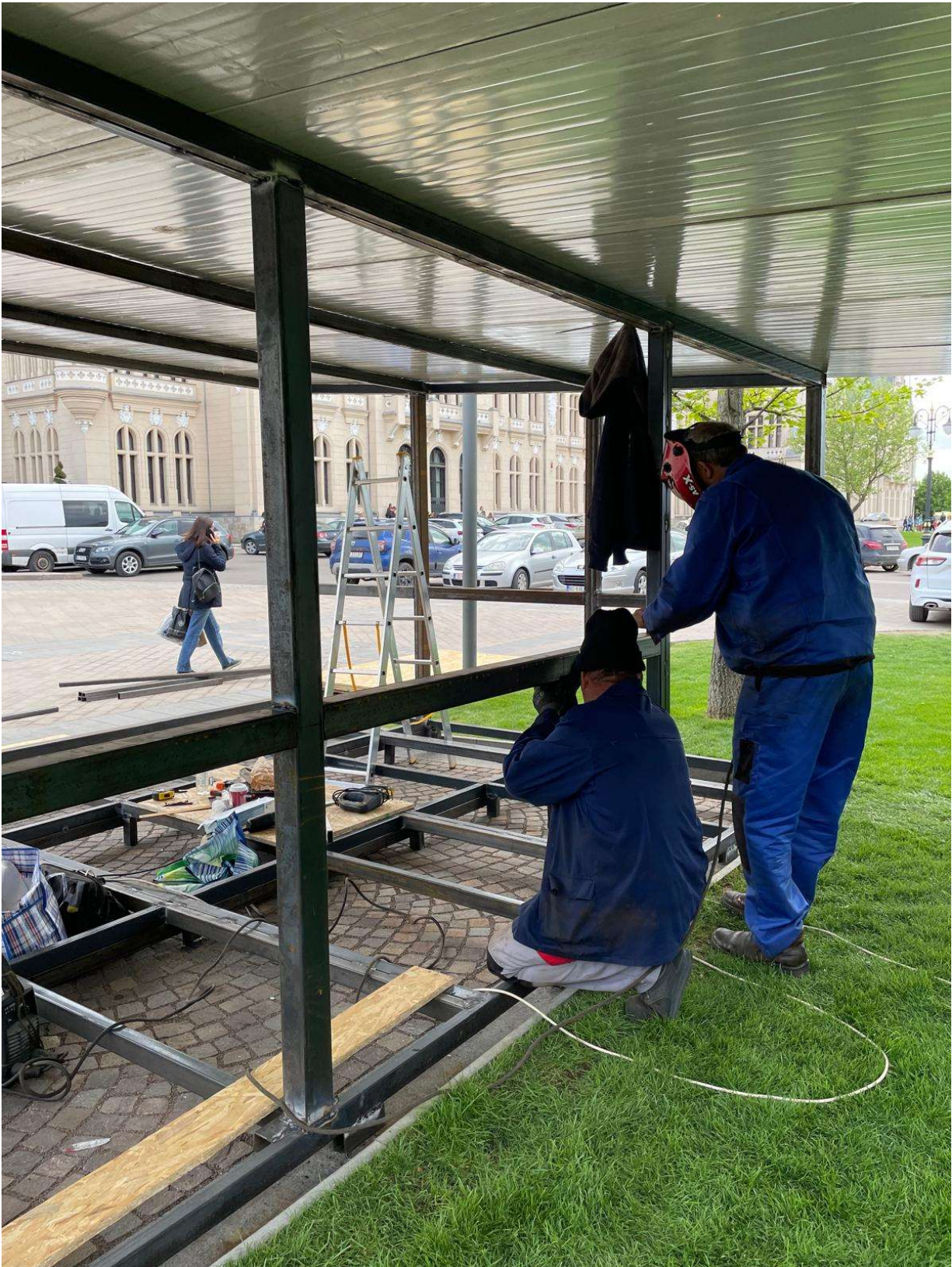
Acoperisul din panouri sandwich
